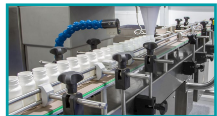
Trabajos de transvase o envasado, procesos de abastecimiento/ transporte
